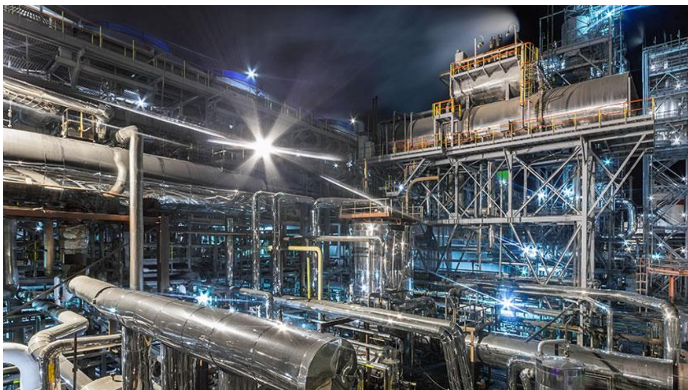
Afbeelding 3: Carbon Capture Storage installation
